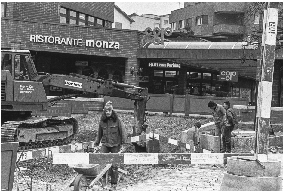
Effretikon neu gebaut! (Foto: Jürg Stauffer)
